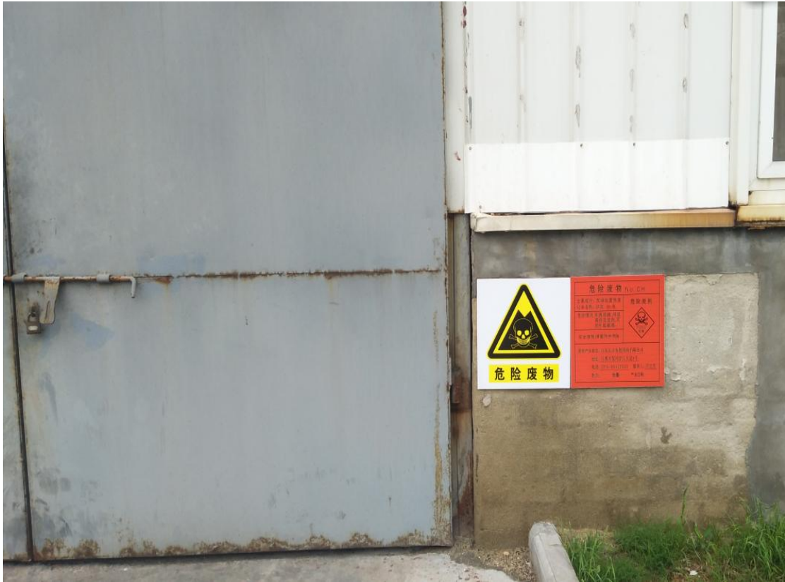
固废存放车间
